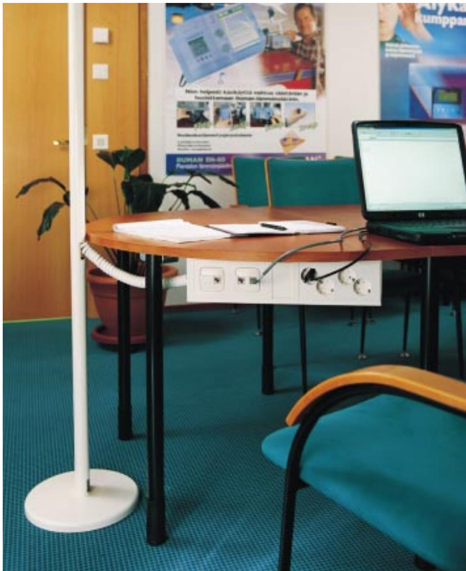
INSTAL SP P сервисная стойка используется вместе с INSTAL SP C распределительным центром. Питающие кабели для распределительного центра проходят через сервисную стойку.
